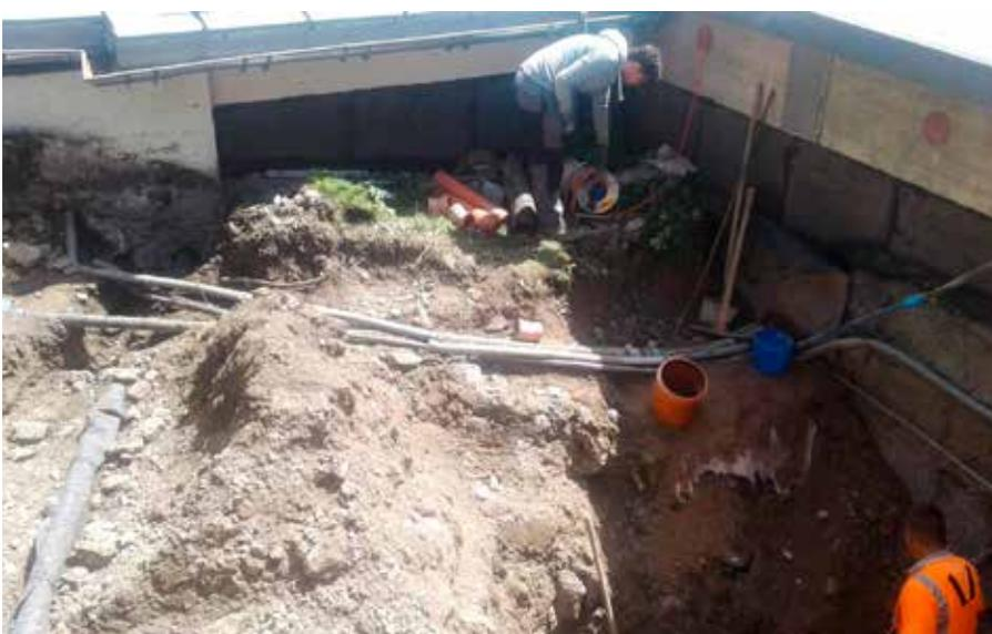
*Anschluss der neuen Trinkwasserleitung für die div. Stall- und Almgebäude, unter Einbindung der zur Keimfreimachung des Wassers auf der Alm bestehenden UV-Anlage.*
