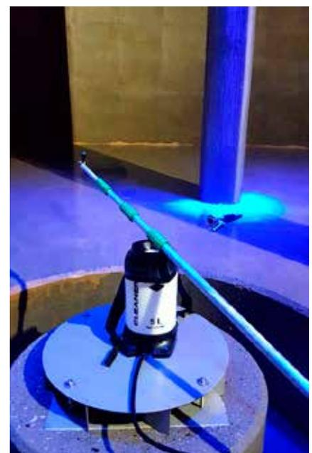
*Reinigung mit Hochdruckkanze und Bürste. Es müssen ca. 2000 m<sup>2</sup> Behälterfläche 2-mal im Jahr von den Mitarbeitern des Wasserwerkes gereinigt werden.*
