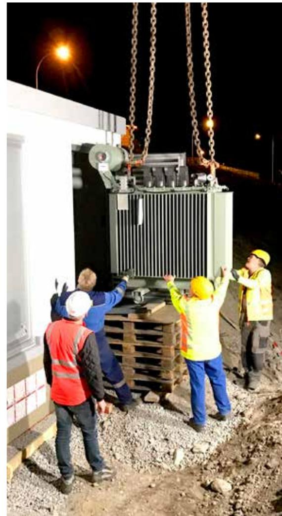
*Die B171 wurde im März gesperrt, um die notwendige Versetzung einer Trafostation mittels Telekran durchführen zu können.*
