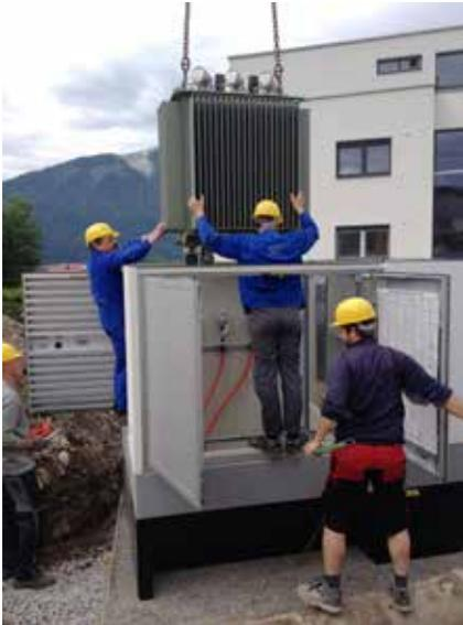
Einführung des neuen Trafos in die neue Fertigteilstation.
