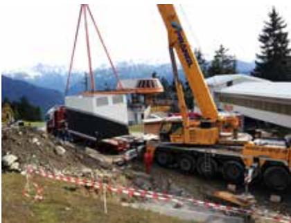
Einbau Fertigteilstation Untermarkter Alm.
